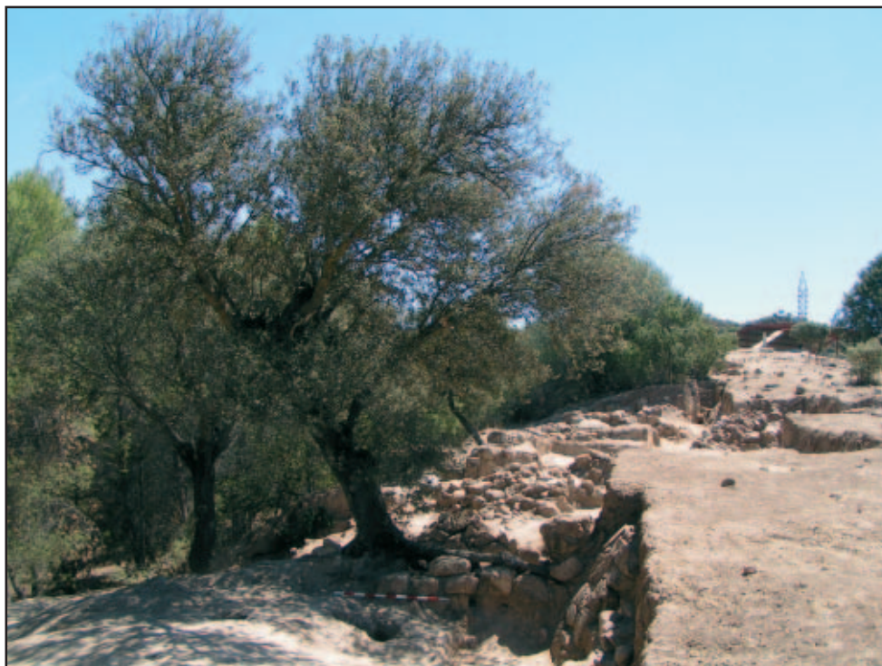
Figura 9. Encina que introduce sus raíces en uno de los bastiones de la muralla.
